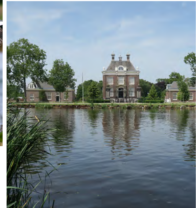
Voorzijde buitenplaats Oostermeer aan de Amstel
