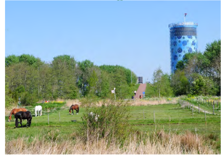
Oprit fietsbrug over de A2 en het ronde Fletcher hotel
