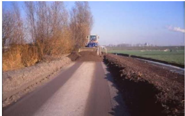
Figuur 8 Aanleg drasse dijkvoet 1990
